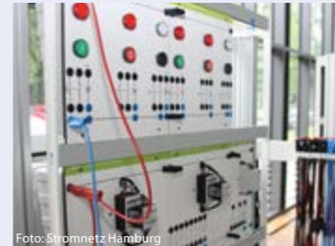
Foto: Stromnetz Hamburg
